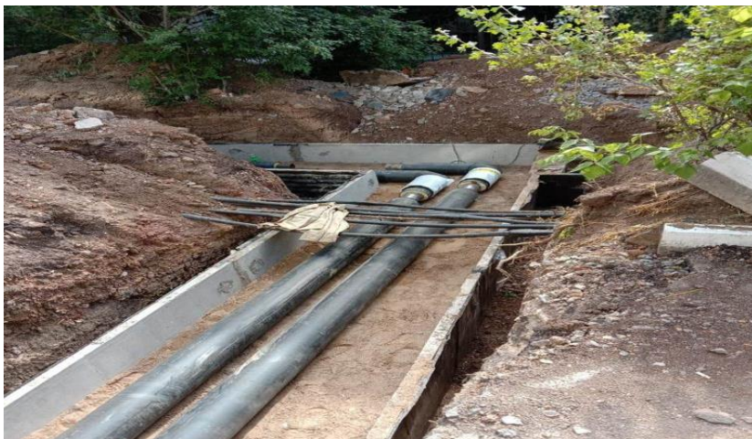
п. 1.7. Реконструкция теплотрассы от УТ6(29) до пр. Абая 9/1, квартал 93, замена Ду 50-150мм
