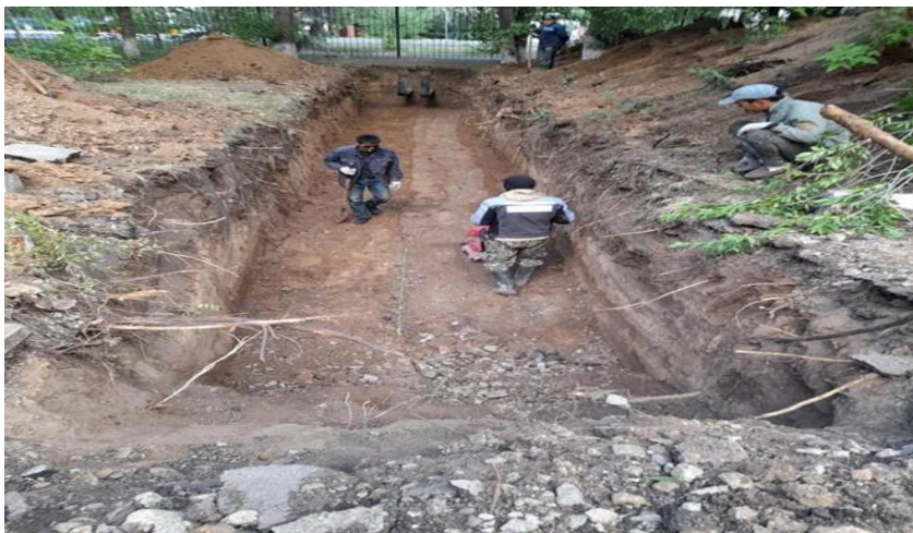
п. 1.8. Реконструкция теплотрассы по ул. Манаса 14, УТ-5(18), замена ДУ 50-150 мм
